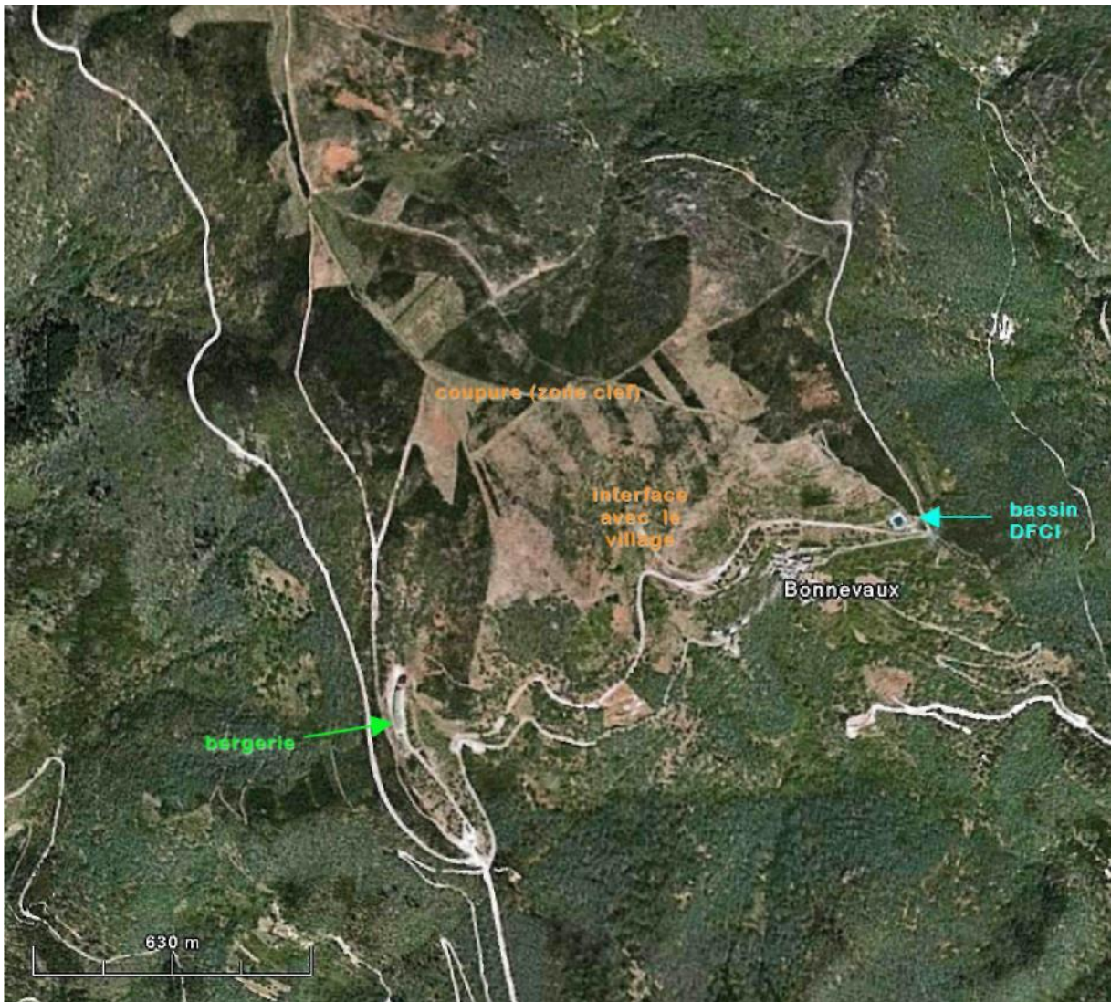
Εναέρια άποψη της διαμορφωμένης ζώνης καθαρισμού
